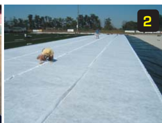
2 - Schema di posa TERRADRAIN FOOTBALL e drenaggi laterali
