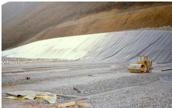
Impermeabilizzazione primaria con JUNIFOL LINER
