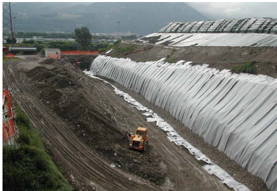
Drenaggi con TERRADRAIN
