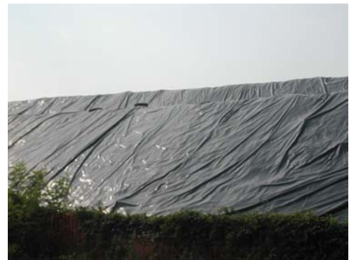
Copertura temporanea con LDPE EDIL LINER
