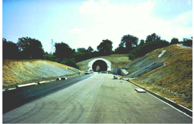
Sistemazione antierosiva zona d'imbocco con ITALGRIMP ed ITALMANT
