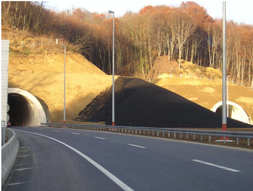
Sistemazione antierosiva zona d'imbocco con ITALGRIMP
