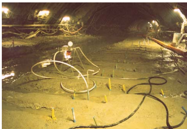
Consolidamento con tubi ITALINJECT
