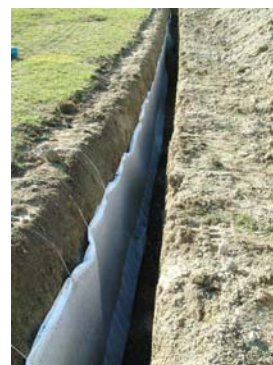
Drenaggio in trincea sottile con TWINDRAIN
