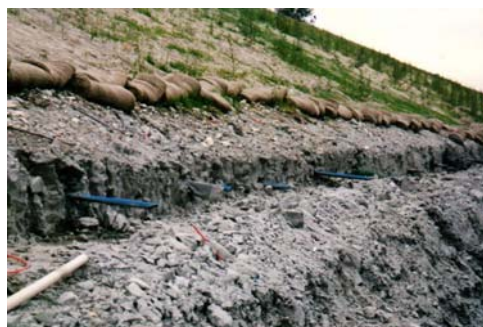
Consolidamento tramite drenaggi al fronte con ITALDREN
