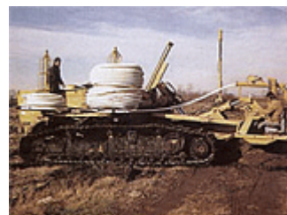
Posa automatica di tubo dreno flessibile ITALFLEX
