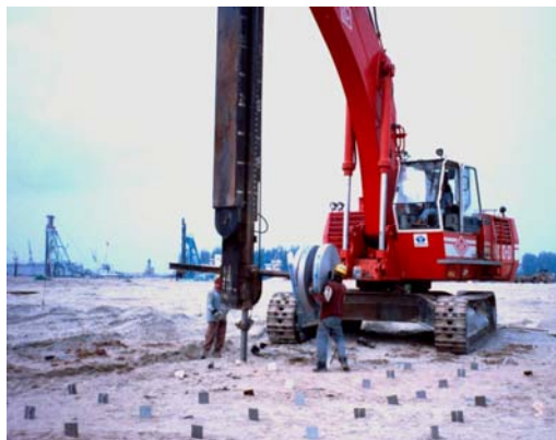
Consolidamento accelerato dei terreni con MEBRADRAIN
