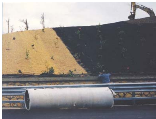
Protezione antierosiva con ITALGRIMP e ITALMANT
