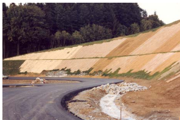
Protezione antierosiva con ITALMANT
