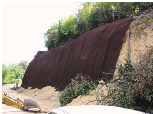
Protezione antierosiva con ITALGRIMP
