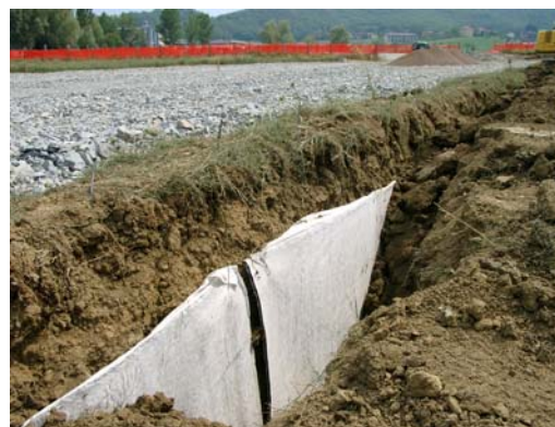
Drenaggio in trincea sottile con TWINDRAIN
