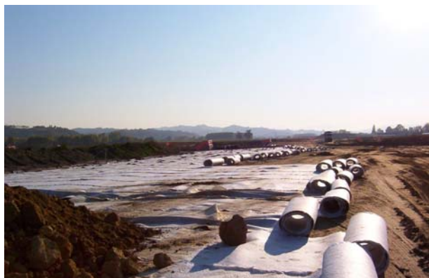
Drenaggio planare di strada con TERRADRAIN D
