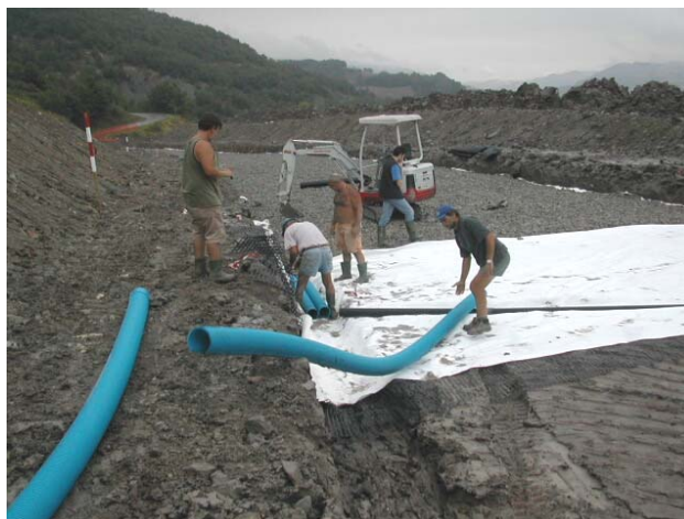
Drenaggio di strada in frana con ITALWELL e ITALPLAST
