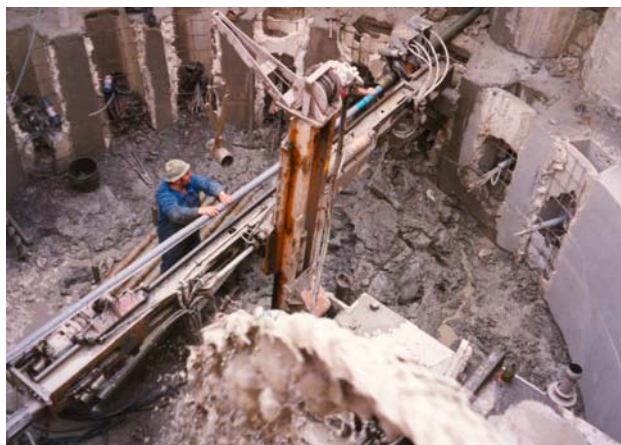
Drenaggio suborizzontale da pozzo drenante con ITALDREN
