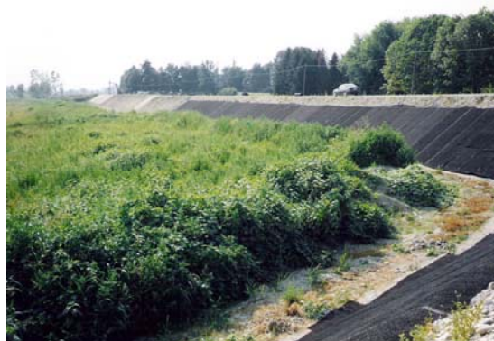
Protezione antierosiva di rilevato con ITALGRIMP
